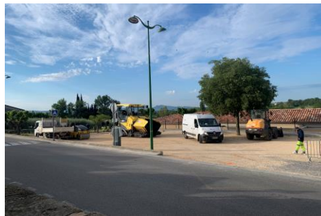
Goudronnage place de la boulangerie
