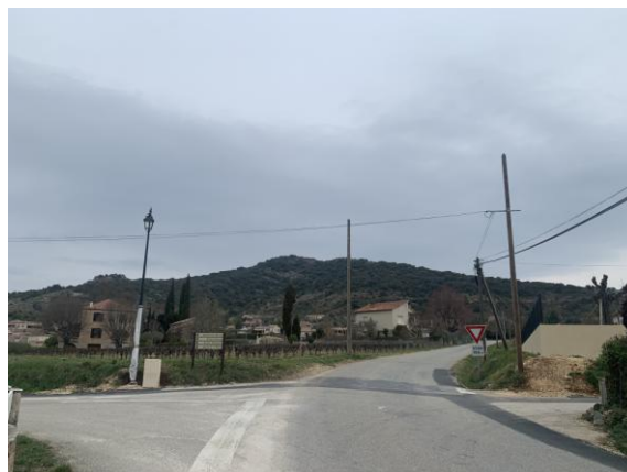
Enfouissement quartier La Rivière
