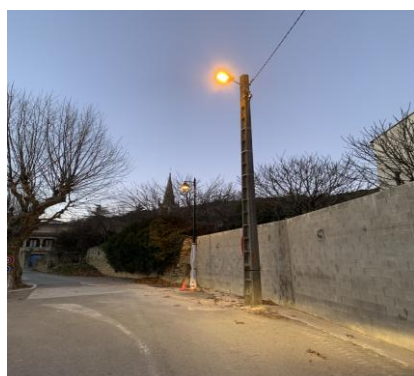
Remplacement ancien candélabre
