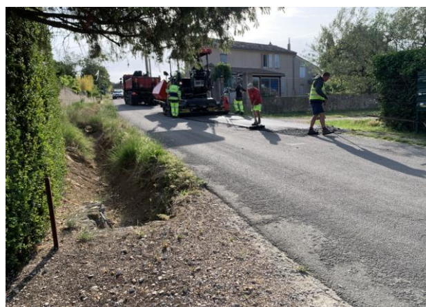
Rebouchage route de Bessas
