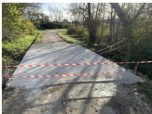
Réfection passage buse chemin Mas Imbert
