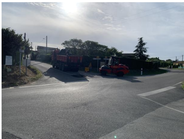
Goudronnage route de Bessas
